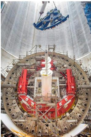
リニア中央新幹線の大深度地下でのトンネル工事に向け準備が進む北品川非常口。トンネルを掘るシールドマシンは地下で組み立てられる＝東京都品川区、JR東海提供
