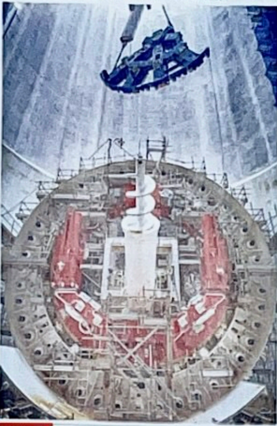
①道路の陥没現場—2020年10月18日、東京都調布市、読者提供 ②リニア中央新幹線の大深度地下でのトンネル工事に向け準備が進む北品川井筒口、トンネルを囲むシールドマシンは地下で組み立てられる—、東京都品川区、J東海提供
